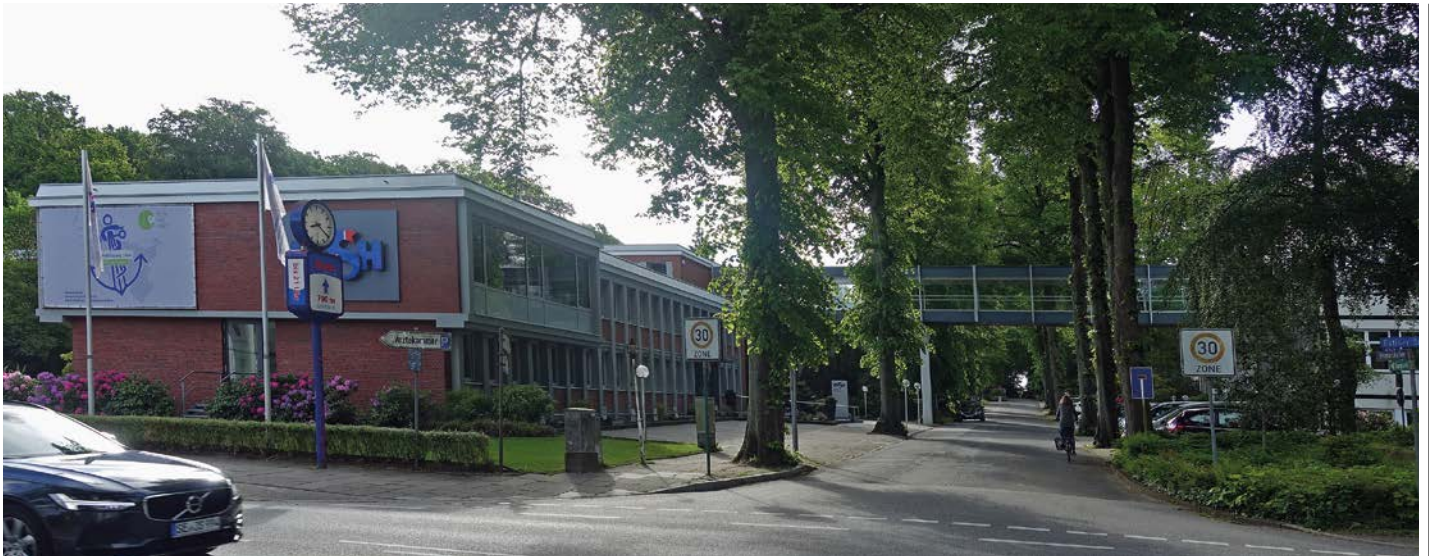
Ansicht der KV von der Eutiner Straße aus.
